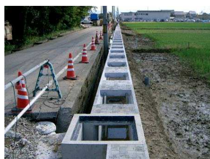
图 3a：工程现场
